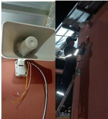
6. Puesta de luz roja de activación de alarma y colocación de tomas eléctricas.
