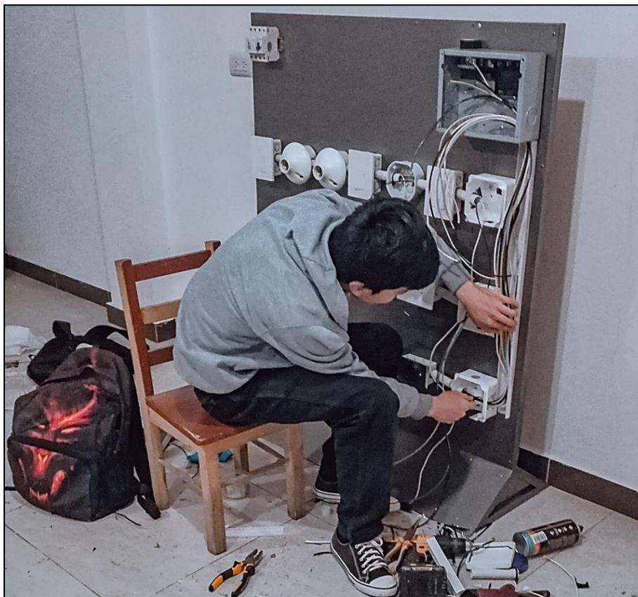
Nota. Enrutamiento de cables, asegurando una conexión segura y eficiente en el tablero de prácticas. Autoría propia.
